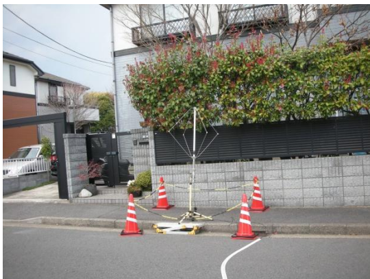
図 3 アンテナ設置場所 A 点設置状況
