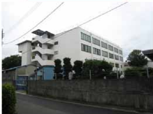
4階建てコンクリート建造物
