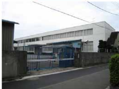
2階建て工場建物
